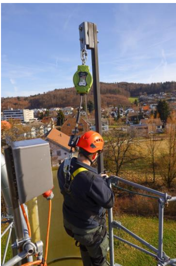
Diversi sistemi DPIaC per l'accesso al silo a torre
