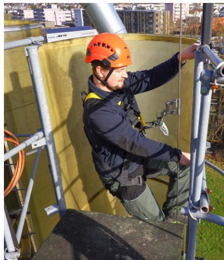
Diversi sistemi DPIaC per l'accesso al silo a torre
