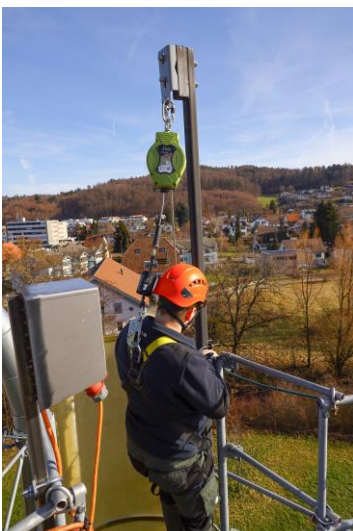
Verschiedene Systeme von PSAgA beim Aufstieg aufs Hochsilo
