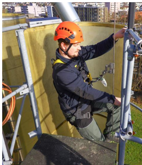
Verschiedene Systeme von PSAgA beim Aufstieg aufs Hochsilo
